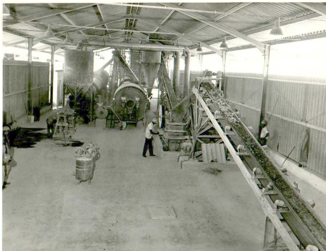
FIGURA 14 - FOTOGRAFIA DAS PRIMEIRAS INSTALAÇÕES NA MINA DE CANABRAVA, ESTADO DE GOIÁS. ANOS 1967-1970.
