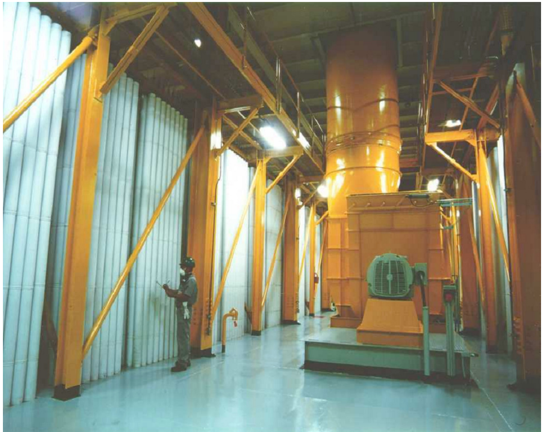
FIGURA 15 - FOTOGRAFIA DA INSTALAÇÃO DOS FILTROS MANGA, PARA O EFETIVO CONTROLE DA EXPOSIÇÃO OCUPACIONAL E AMBIENTAL – ANO DE 1980.
