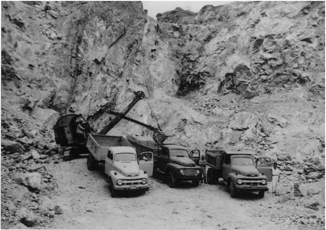
FIGURA 3 - FOTOGRAFIA DA FRENTE DE LAVRA (CAVA). EXTRAÇÃO E TRANSPORTE DO MINÉRIO. PERÍODO DE 1950-1960.
