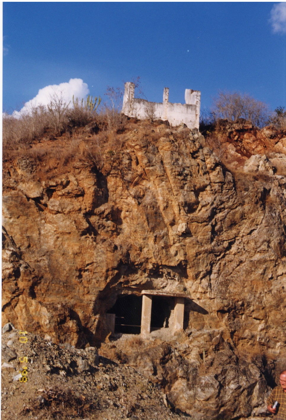
FIGURA 8 - FOTOGRAFIA DAS RUÍNAS DA UNIDADE DE MOAGEM. MAIO DE 1998.
